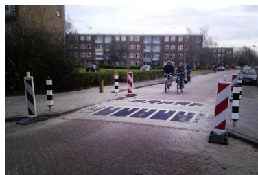
Foto: Wegversmalling elders in het land waarbij reflectie is toegepast om de verhoging in het donker te zien.
