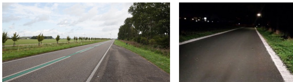
Foto: Belijning die reflecteert waardoor het verloop van de weg goed te zien is.
